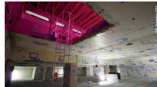
↑ Assainissement-démantèlement du laboratoire d'analyse des matériaux actifs. État final d'un couloir après écroutage des surfaces et contrôles radiologiques.
